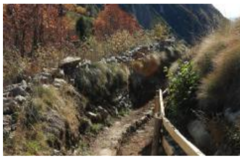
La trincea con il gradino a servizio dei fucilieri
