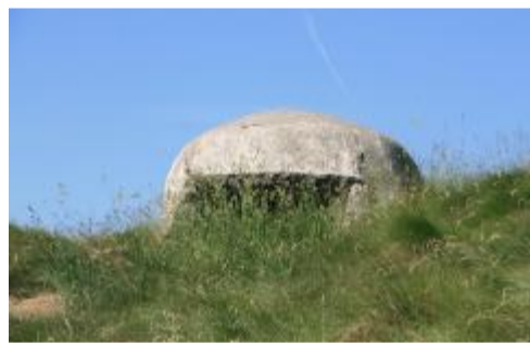
Il bunker in cemento armato che svetta tra il verde
